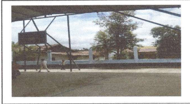
Foto 2: Circulación en mal estado, malla rota, tubo doblados y oxidados.
